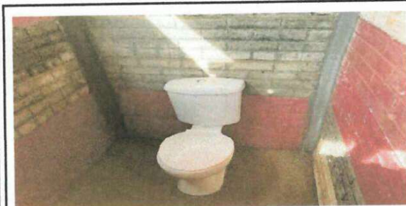
Foto # 5: Instalación de baños.
