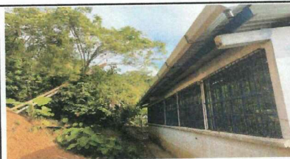
Foto # 4: Sustrucción de balcones.
