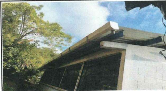
Foto# 2: Sustrucción de canales.
