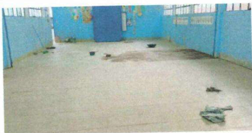
Foto # 3: Sustitución e instalación de piso ceramico, aula 1
