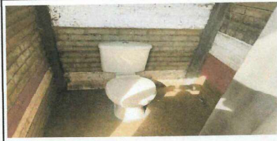
Foto # 6: Instalación de baños.
