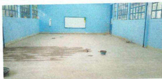
Foto # 4: Sustitución e instalación de piso ceramico, aula 2
