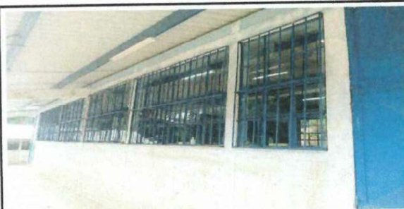
Foto # 3: Sustrucción de balcones.
