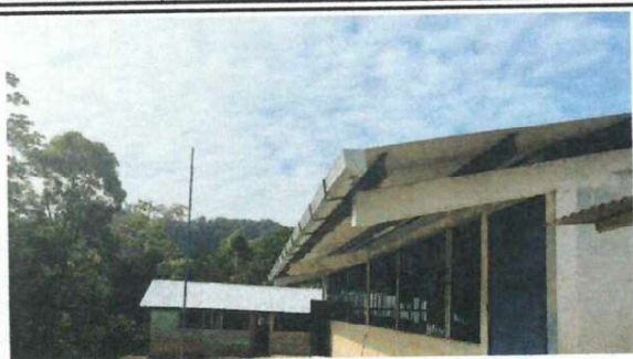
Foto # 1: Sustrucción de canales.
